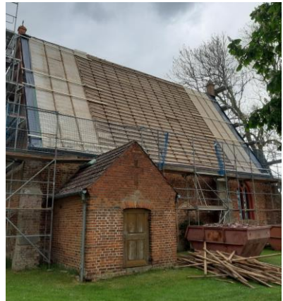
Die Arbeiten am Dach beginnen.
