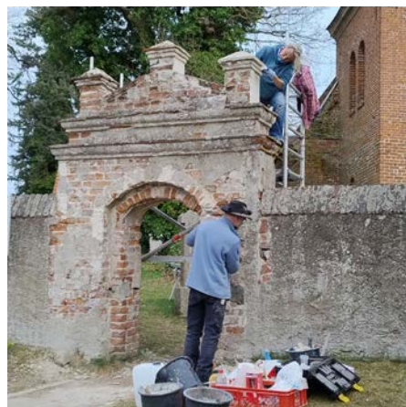
Die Restauratoren bei der Arbeit
